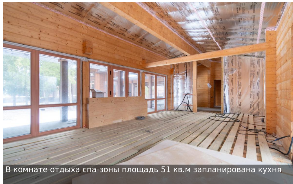
Спа-зона - под отделку. Запланированы: парная 14 кв.м, комната отды
